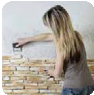
3. J'encolle le mur*
